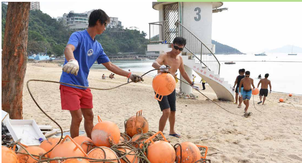
超强台风山竹袭港后造成严重破坏，本署人员在重新开放泳滩前，先处理损毁的泳滩设施。
